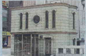
●外壁大谷石採用
