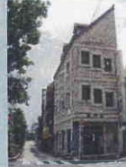
●外壁大谷石採用
