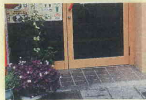
●段差のない出入口
